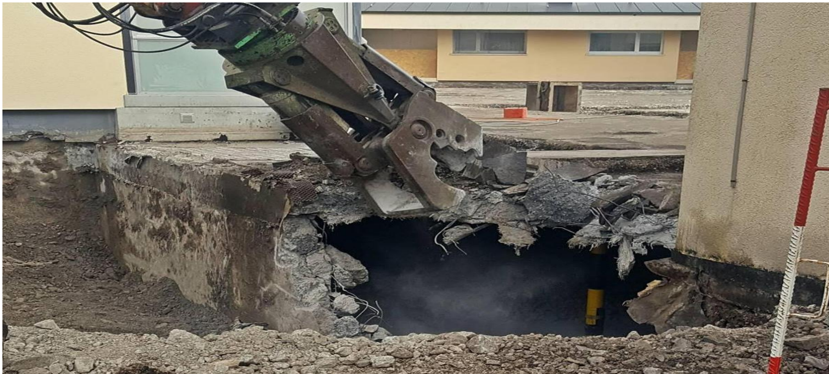
Der «Betonfresser» frisst sich in die Einstellhalle der BWG Thun.
